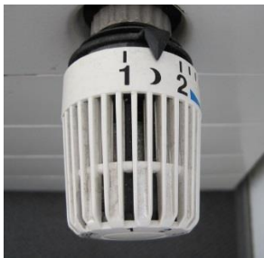
Bild 3: Temperaturregler am Heizkörper
